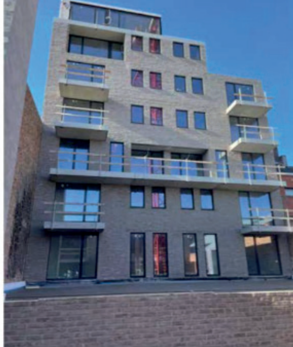
Achterein zijn de gevels bekleed met een grijze gevelsteen.
