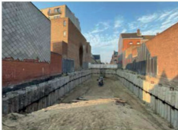
Het uitgraven van de 7 meter diepe kelder bracht de nodige uitdagingen met zich mee.
